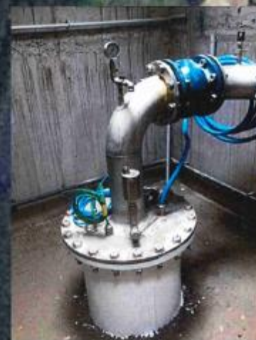
Exemple d'aménagement de tête de puits
