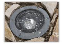
Avec le temps, nombres de projecteurs halogènes encastrés dans le sol n'étaient plus étanches et plus réparables (en cause, des contraintes thermiques liées de ce type d'éclairage).
